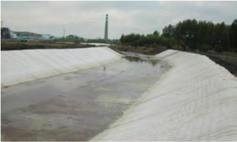
图 2 膜袋混凝土护坡
